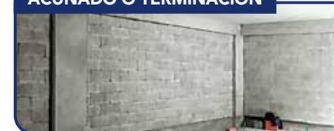
Para el sistema de acuñado o terminación del tabique lo indicado es un **sistema de espuma de poliestireno**; no obstante puede ser realizado con mortero tradicional.
