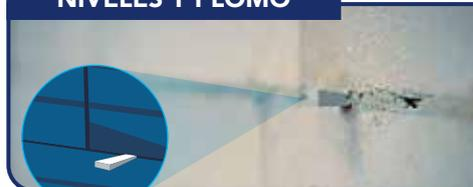
En caso de existir problemas de nivelación y plomo durante la elevación del tabique, se indica la utilización de **cuñas de nivelación** para ajustes  $\leq$  a 3mm.
