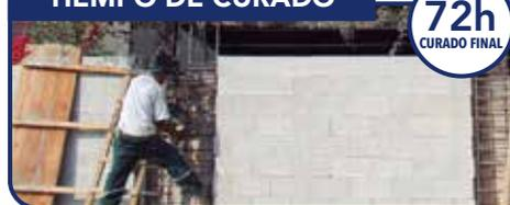
El secado inicial del producto se produce entre 8 a 12 horas, en el cual el tabique adquiere una resistencia apta para la continuidad del proceso constructivo. La resistencia y curado final se alcanza después de **72 horas**. El tiempo de curado puede ser afectado en función de los tipos de bloques utilizados, condiciones meteorológicas y carga de humedad de las superficies previo a la elevación del tabique.
