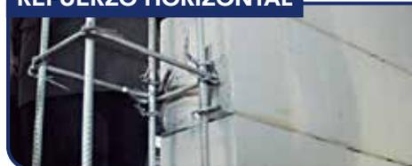
En la construcción de un muro de albañilería confinada, cada 3 hiladas se debe usar dos **flejes de metal paralelos** de 25mm de ancho por 0.8mm o de 1mm de espesor, considerando 2,5 veces la longitud según el tipo de ladrillo o bloqueta que se utilice.
