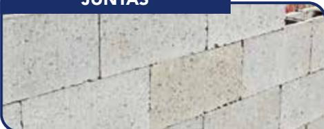
Por su alta capacidad de **adherencia comprobada**, es suficiente la aplicación en la superficie horizontal del ladrillo o bloqueta. Si el muro no va ser tarrejeado, se puede rellenar la junta vertical finamente después de haber construido el muro.
