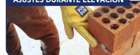
Una vez aplicados los hilos en junta horizontal sobre la superficie del ladrillo, se indica un tiempo máximo de corrección, asentamiento o colocación de los ladrillos de **10 a 15 minutos**.
