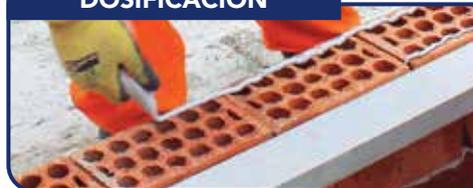
Aplique dos líneas continuas de **1 cm de diámetro** sobre la superficie horizontal del ladrillo o bloqueta.
