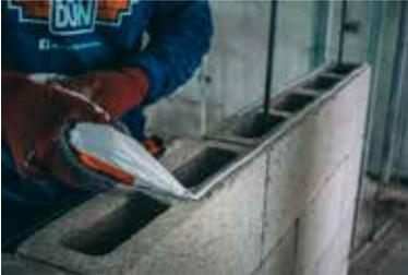
La albañilería armada, actualmente está abarcando cerca al 50% del mercado en proyectos inmobiliarios y centros comerciales, esto es debido a la reducción de tiempo de ejecución en su proceso constructivo, mejor aislamiento térmico, resistencia al fuego, su sistema constructivo tiene mejor comportamiento sísmico ante fallas por fricción y cargas transversales a su plano. A diferencia de los muros confinados asentados con ladrillos de arcilla.
